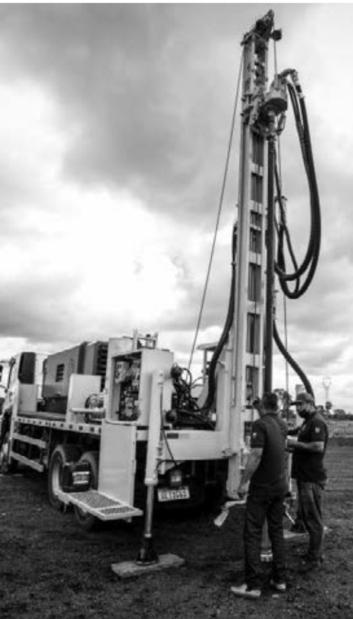
Abertura de poços é feita por perfuratriz
