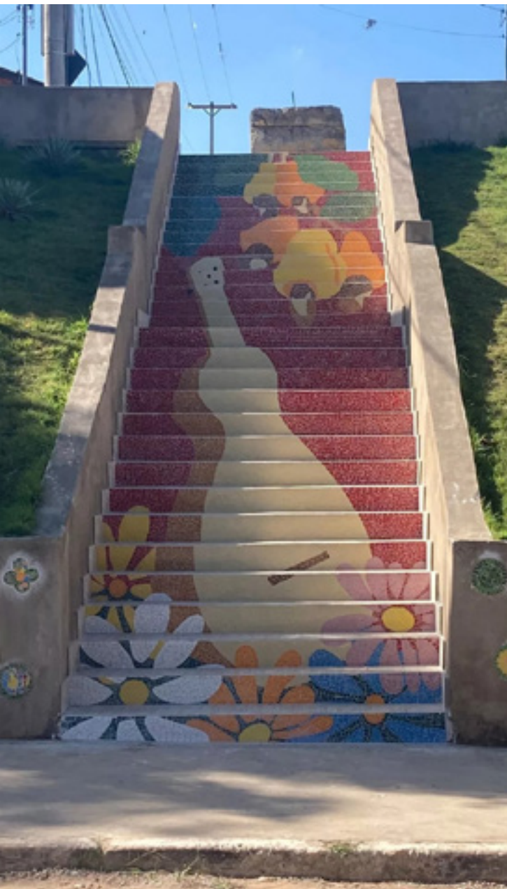
Obra no bairro São João Del Rey
