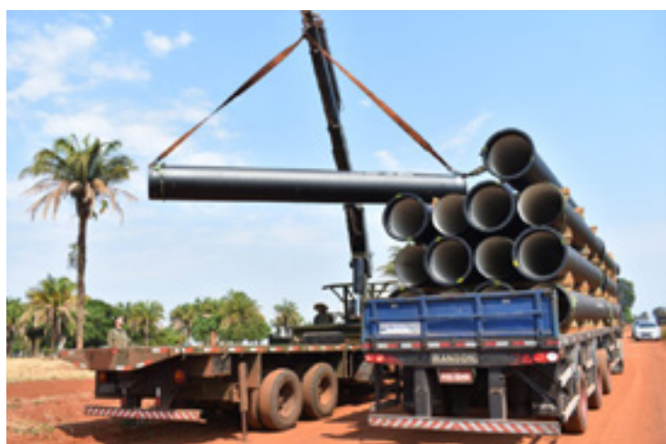
Serão aproximadamente 15km de tubulação
