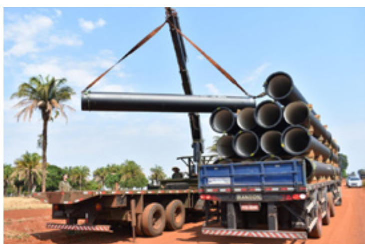
Serão aproximadamente 15km de tubulação
