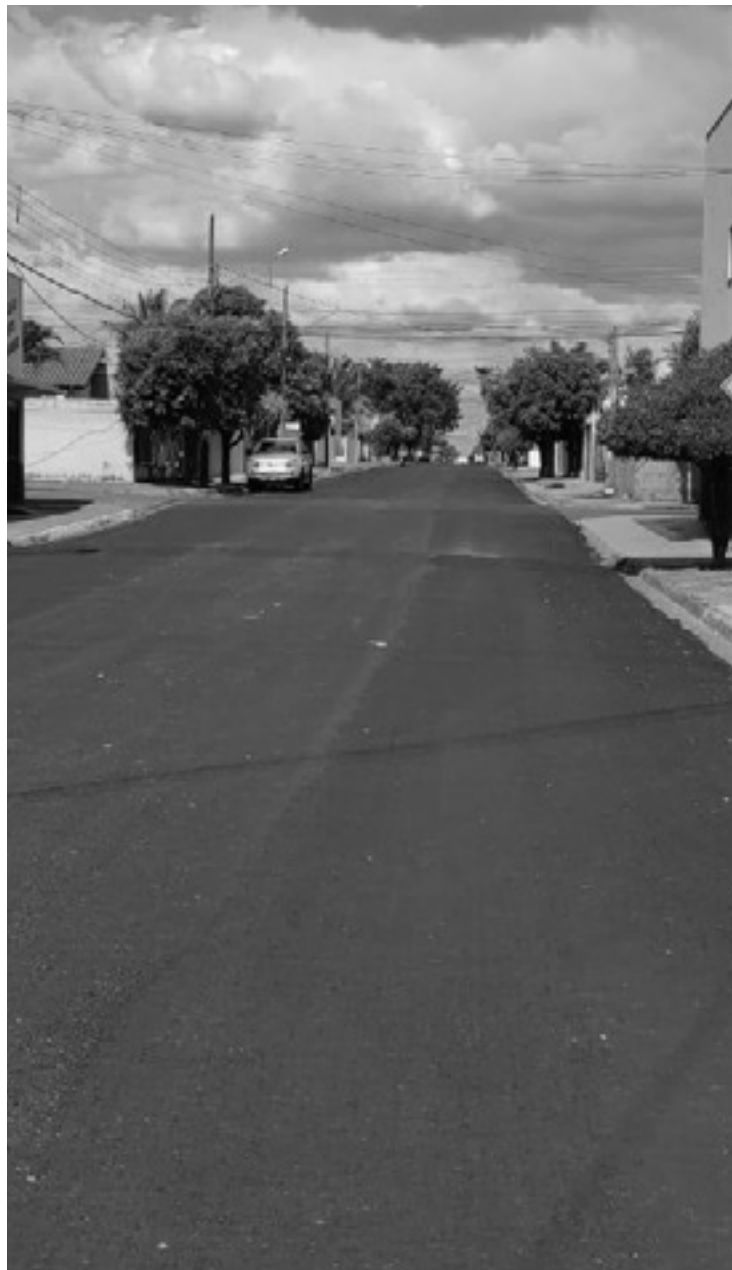
Trabalho foi finalizado na rua 24
