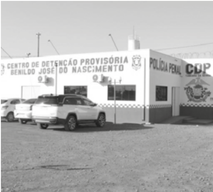
A unidade está passando por melhorias
