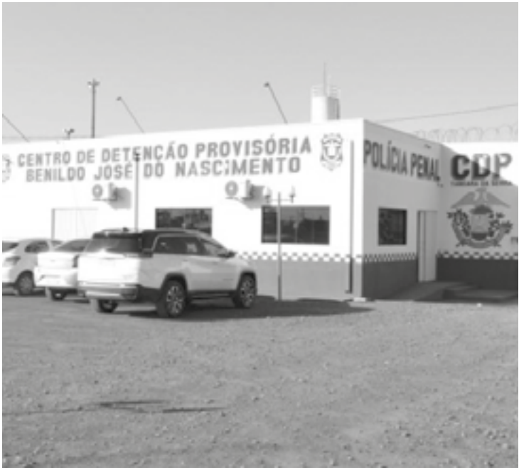
A unidade está passando por melhorias
