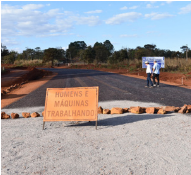
Pavimentação está sendo feita pela Guaxe Construtora
