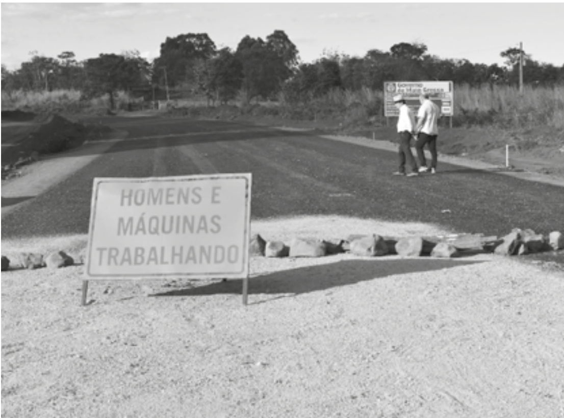
A pavimentação do trecho está sendo feita pela Guaxe Construtora
