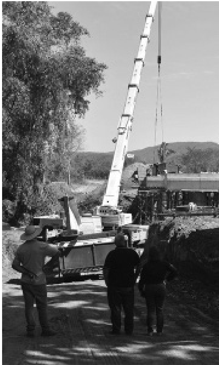
Colocação das vigas de concreto
