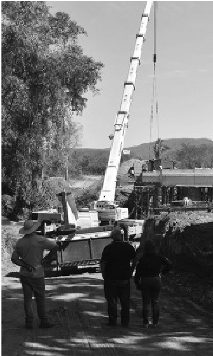
Colocação das vigas de concreto
