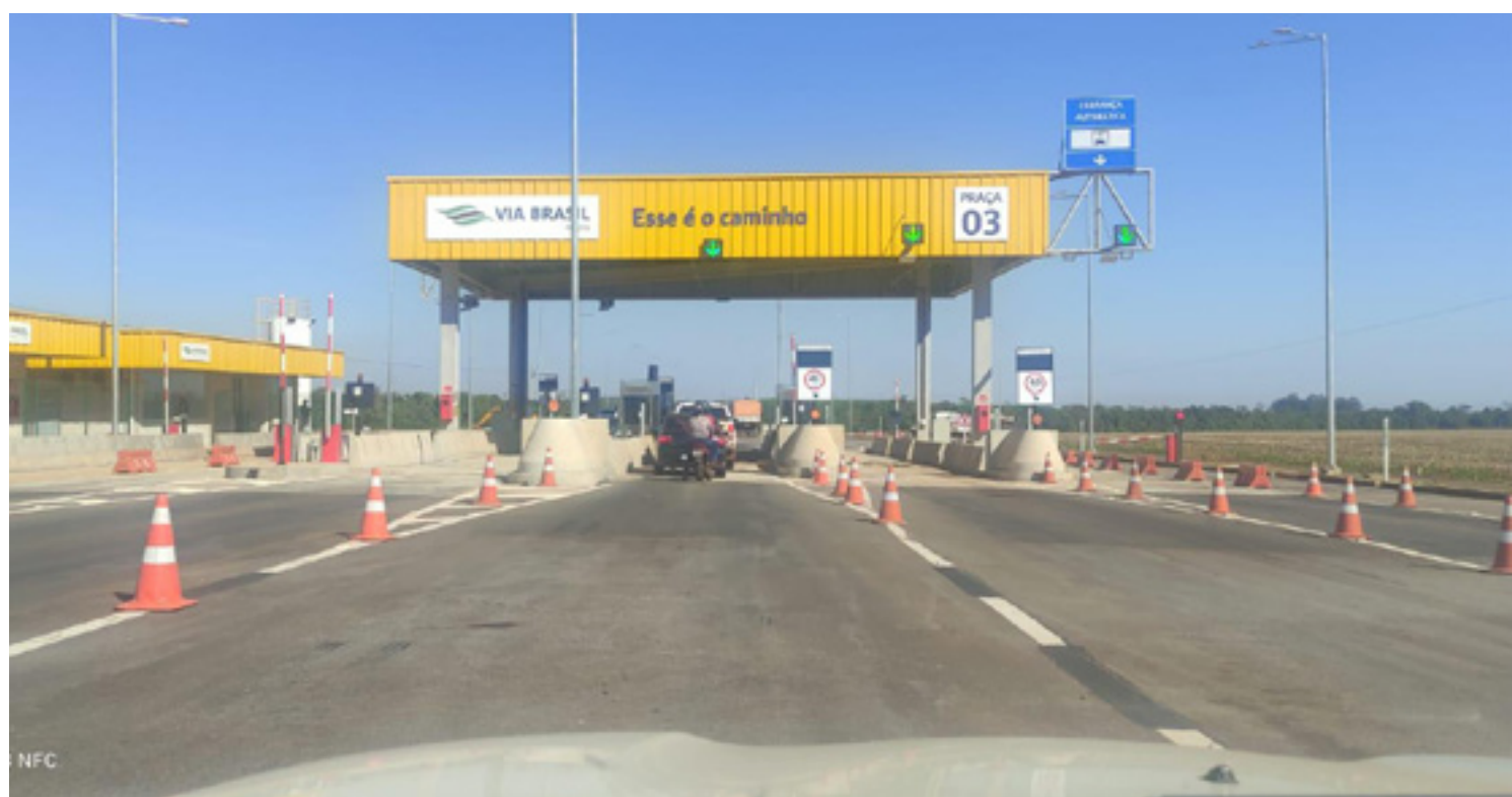
Praça de Pedágio P3VB, localizada no km 138 da Rodovia MT-35
