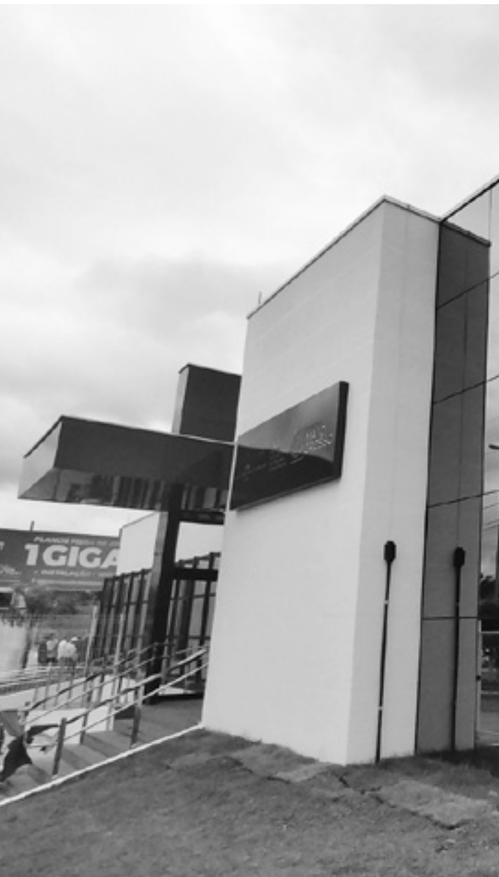
A obra foi construída com recursos do FESA e FASE-MT
