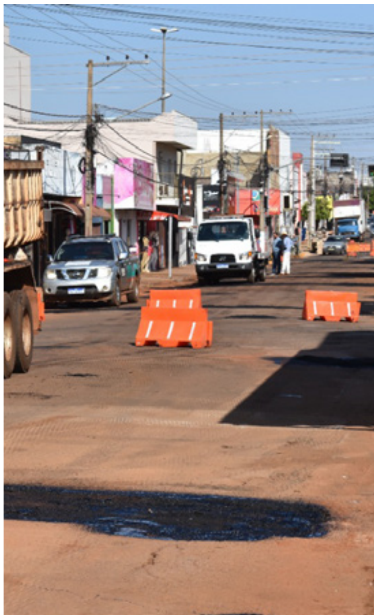
Rua 26 receberá a aplicação do CBUQ
