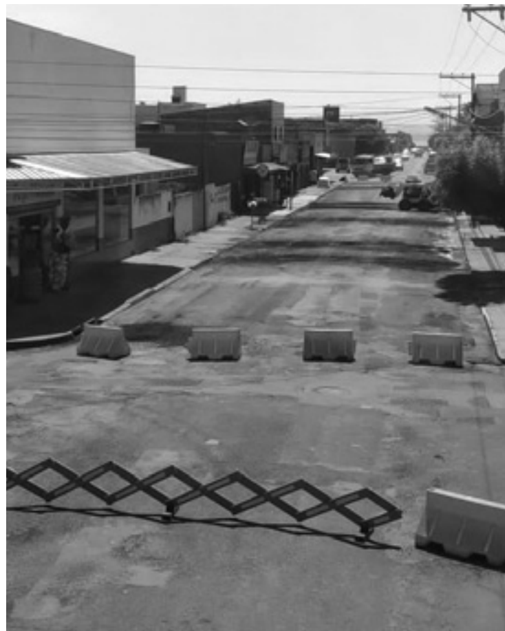
Rua 26 receberá a aplicação do CBUQ
