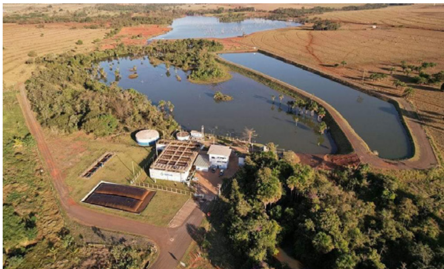
Estação de Tratamento de Água Queima Pé
