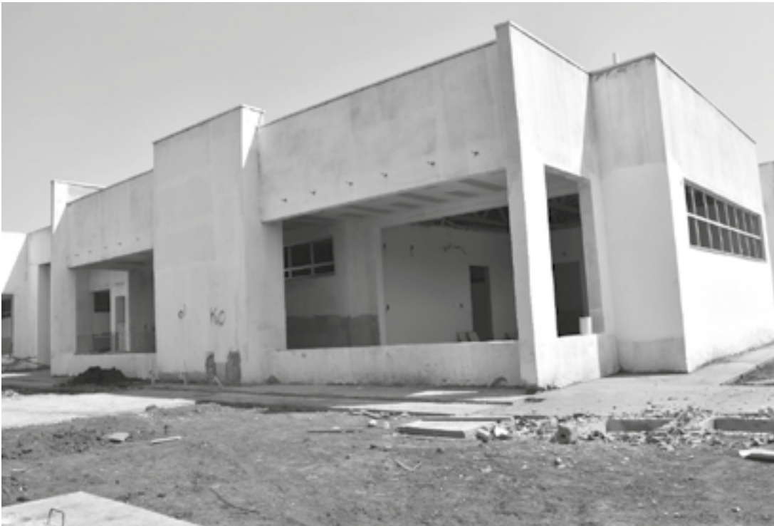
Creche em construção
