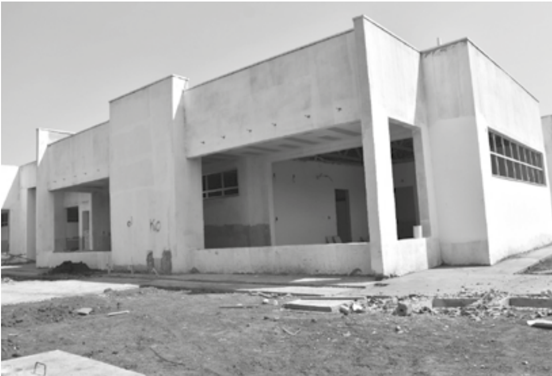
Creche em construção
