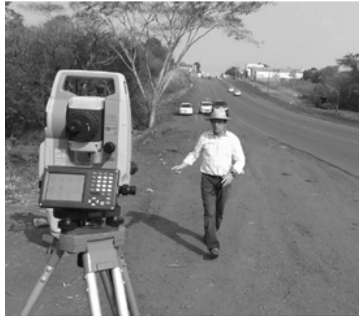
Boa parte da segunda pista já tem a terraplanagem pronta
