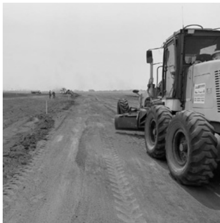
Canteiro de obras instalado
