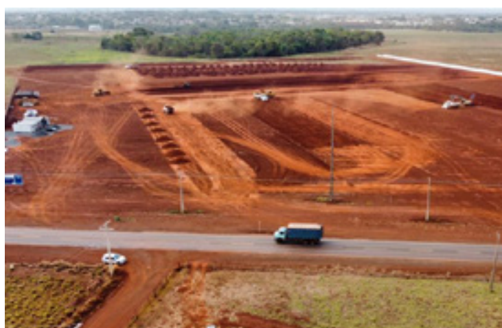
Canteiro de obras instalado
