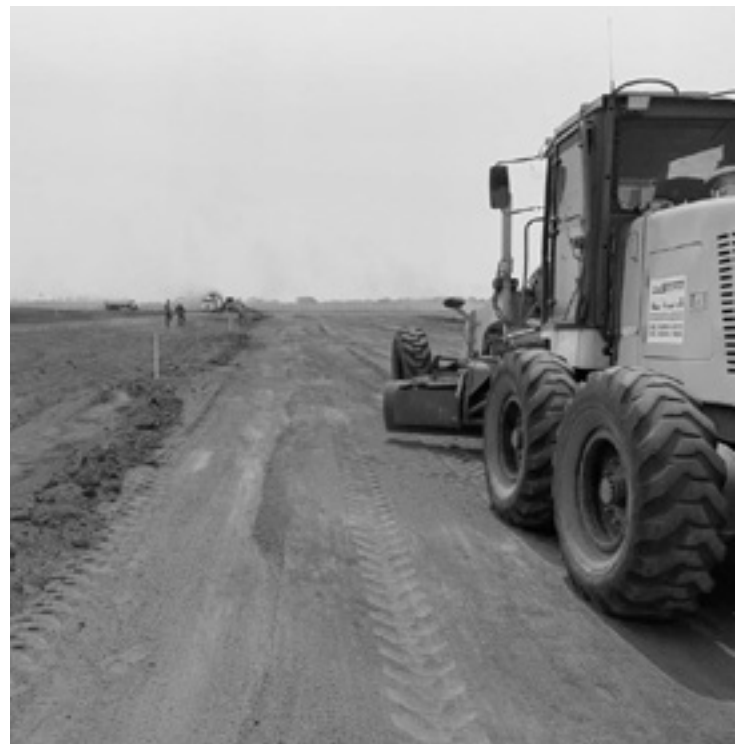
Canteiro de obras instalado
