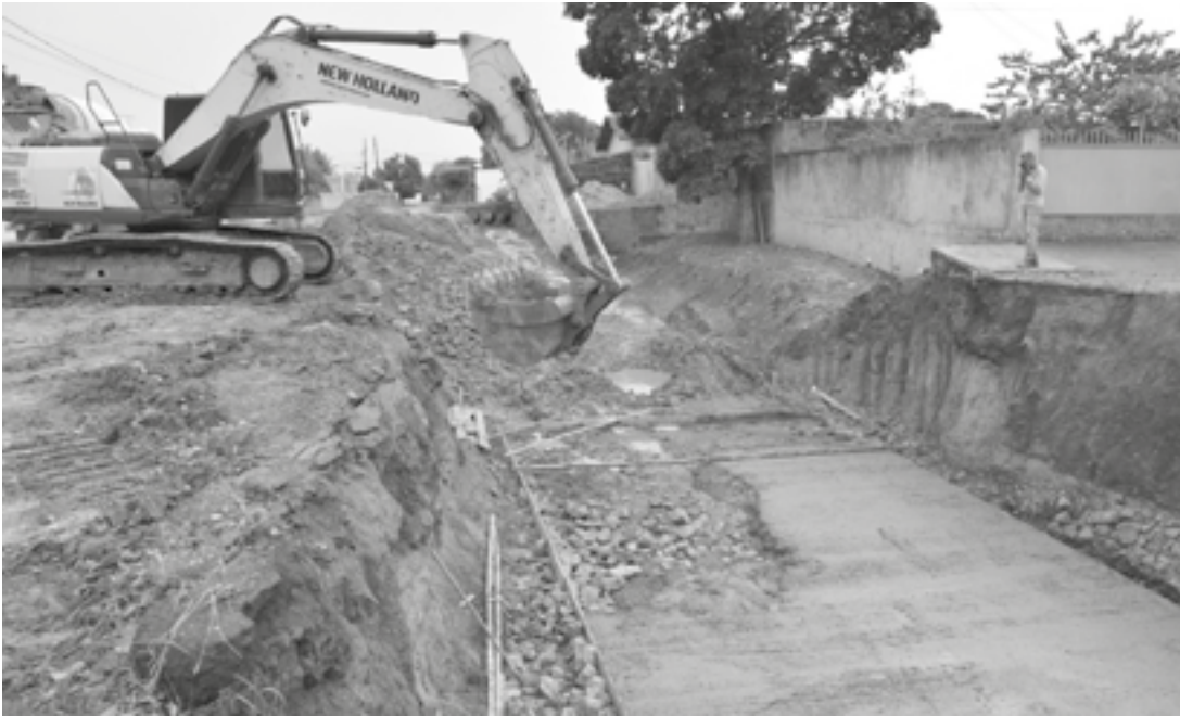
Obras para canalização da água das chuvas
