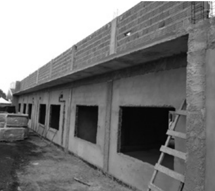
Ao final das obras, a creche dobrará sua capacidade
