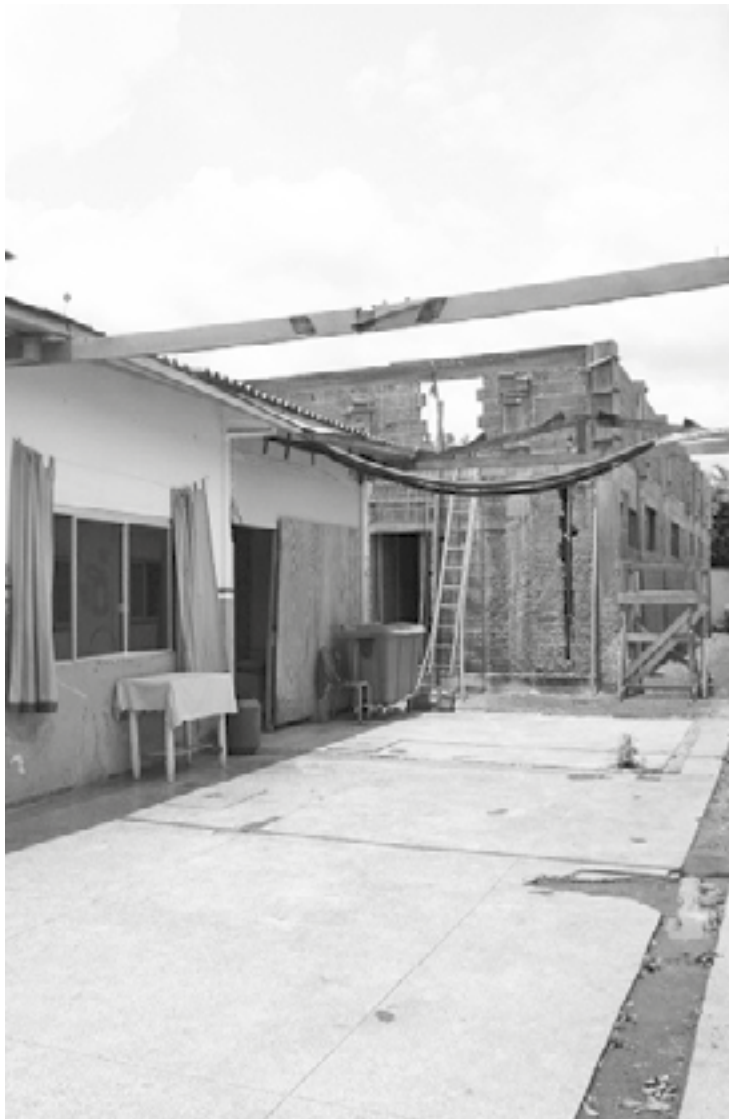
Obras em andamento
