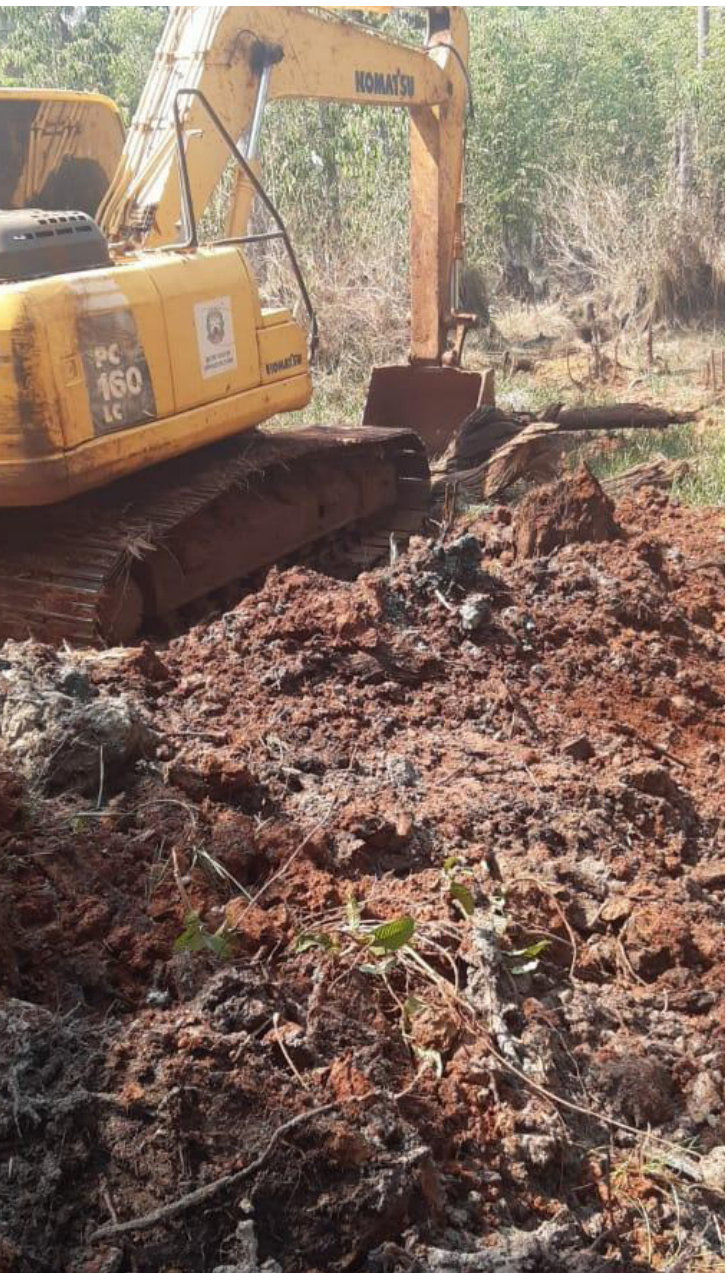
Ampliação elevará capacidade de tratamento de água
