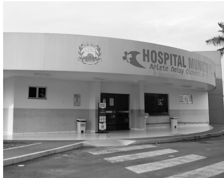
Centro cirúrgico para o Hospital Municipal
