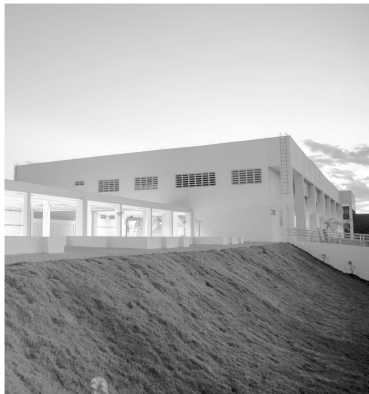
Escola Técnica Estadual de Água Boa
