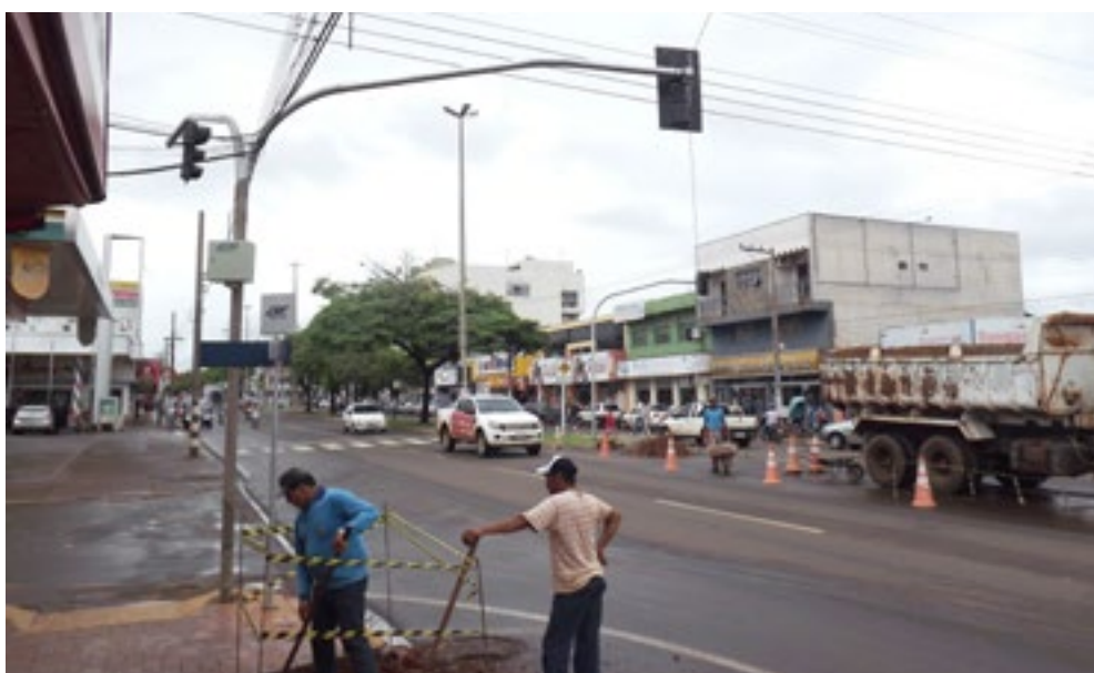
Instalações elétricas serão finalizadas ainda hoje nos dois novos conjuntos semafóricos
