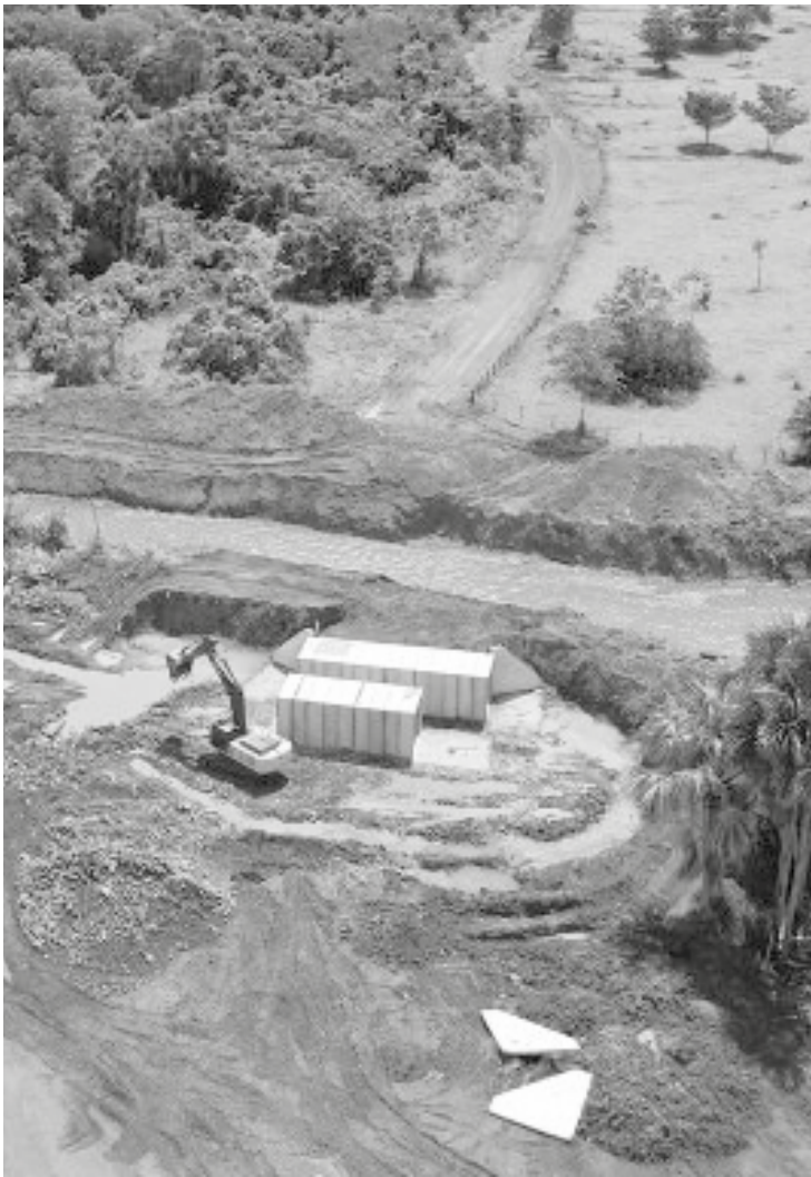
Substituição da ponte de madeira por bueiro
