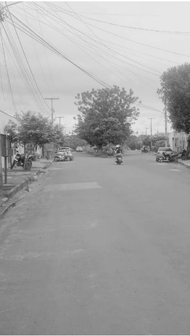
A obra foi iniciada em 2018 e paralisada em 2020
