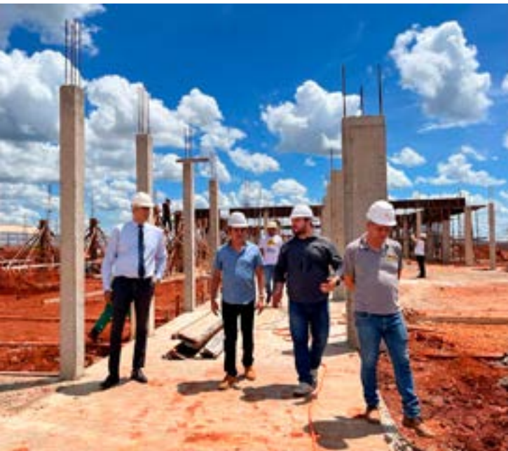
Visita ao canteiro de obras
