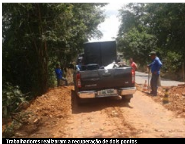
Trabalhadores realizaram a recuperação de dois pontos
