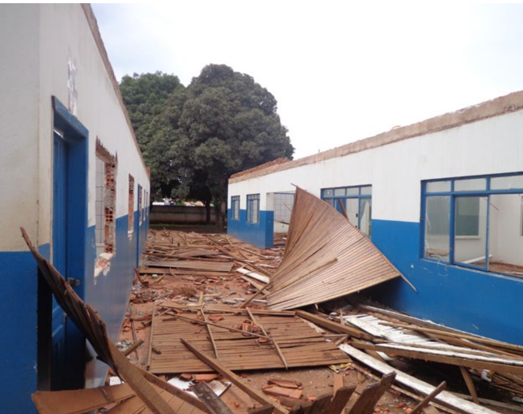
Os pavilhões da unidade estadual já começaram a ser demolidos
