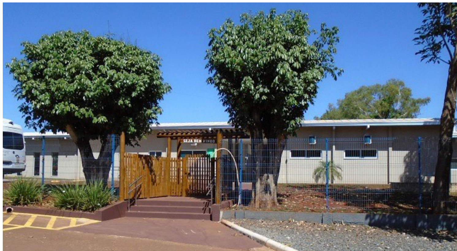
As obras transformaram a Casa do Idoso
