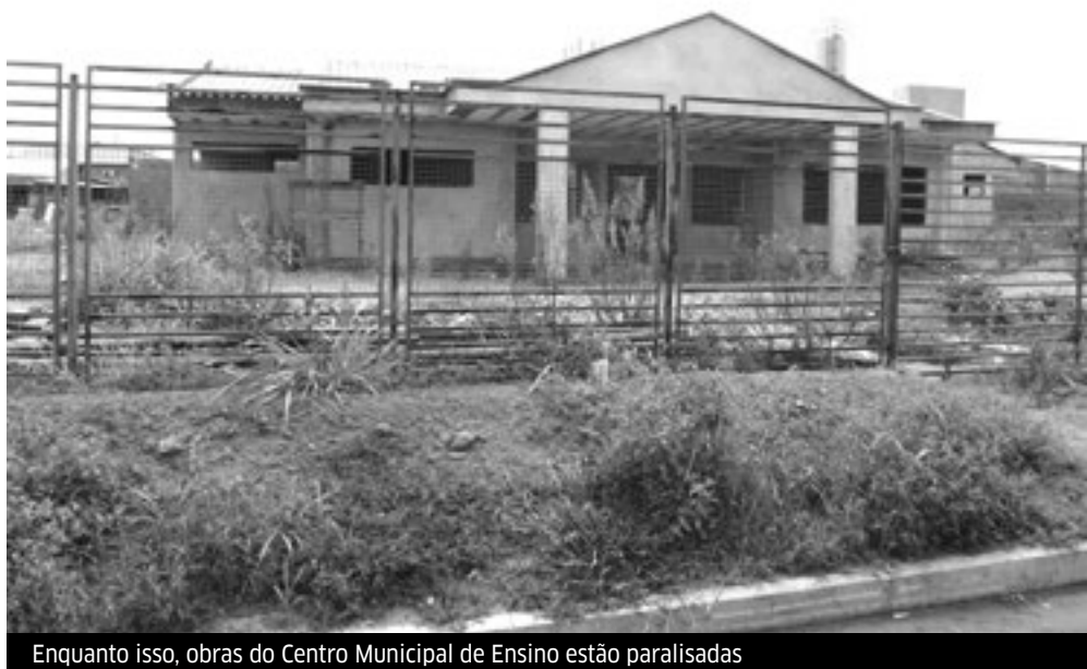
Enquanto isso, obras do Centro Municipal de Ensino estão paralisadas
