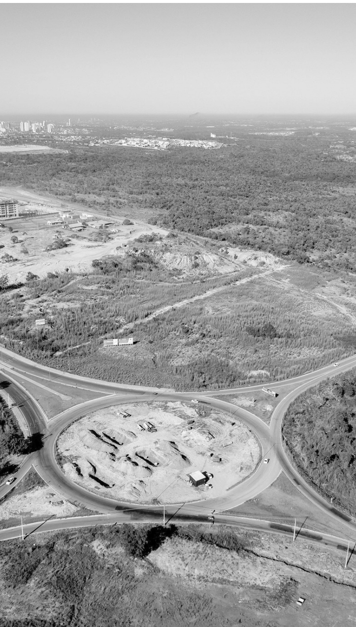
Obra do Rodoanel no viaduto com a MT-010
