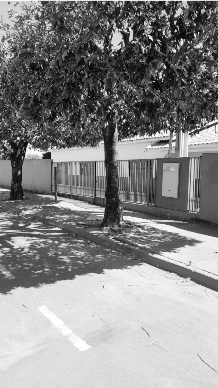
Estrutura deverá passar por melhorias, com custo de R$450 mil
