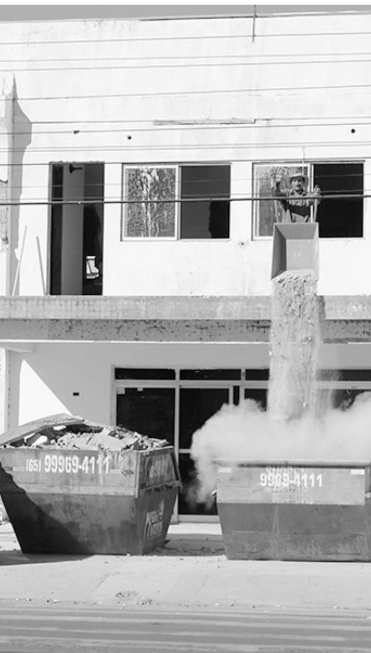
Hospital está sendo reformado
