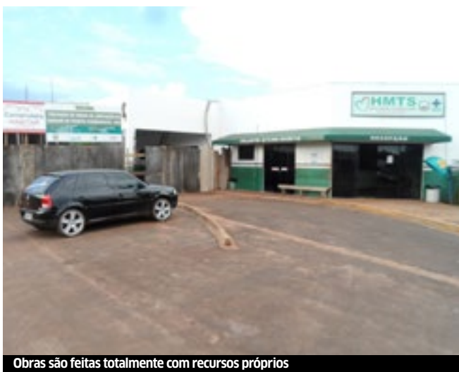
Obras são feitas totalmente com recursos próprios
