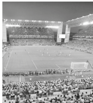
Infraestrutura do estádio
