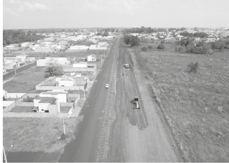
Máquinas estão trabalhando inicialmente na terraplanagem
