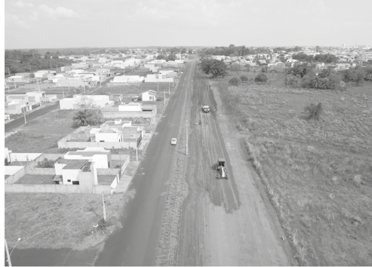
Máquinas estão trabalhando inicialmente na terraplanagem
