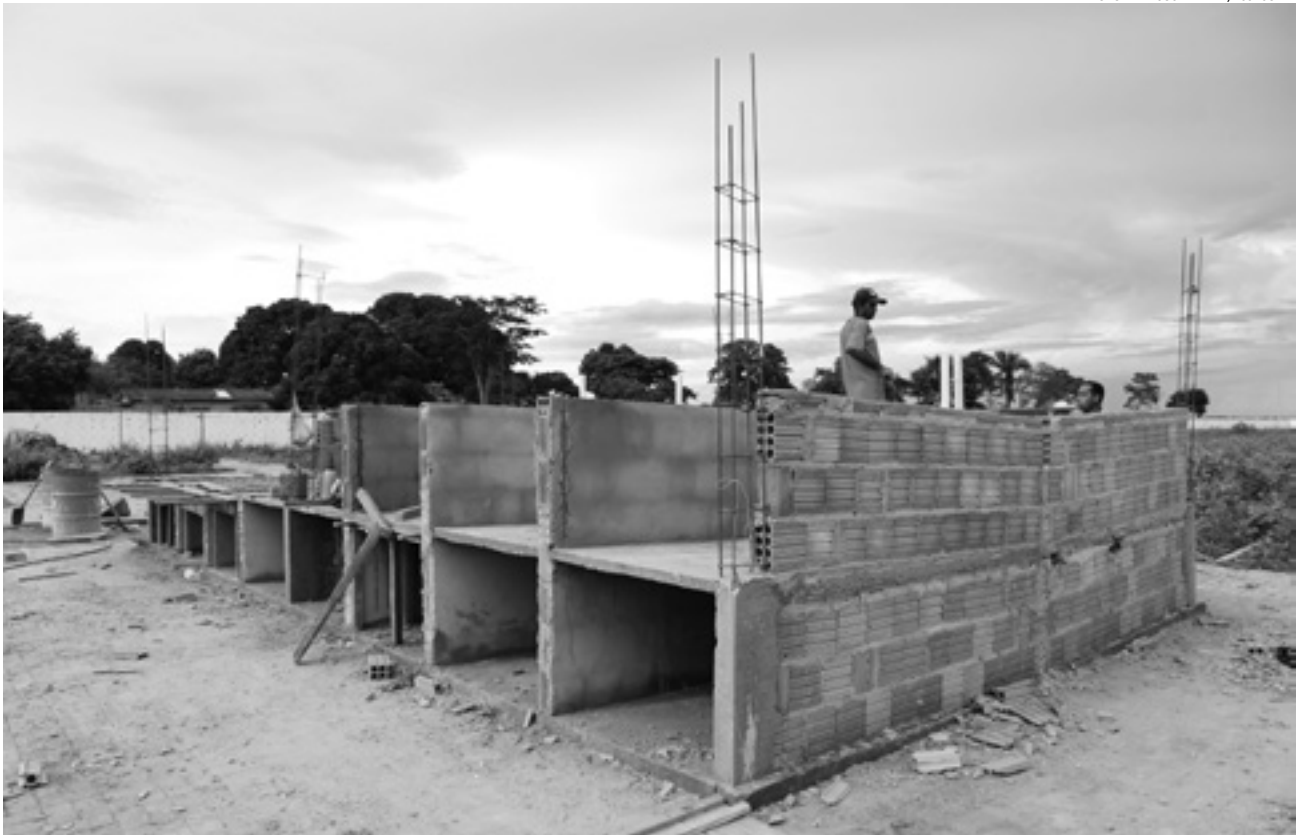
A construção atende as exigências da legislação ambiental
