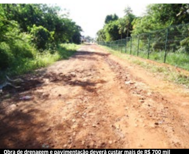
Obra de drenagem e pavimentação deverá custar mais de R$ 700 mil
