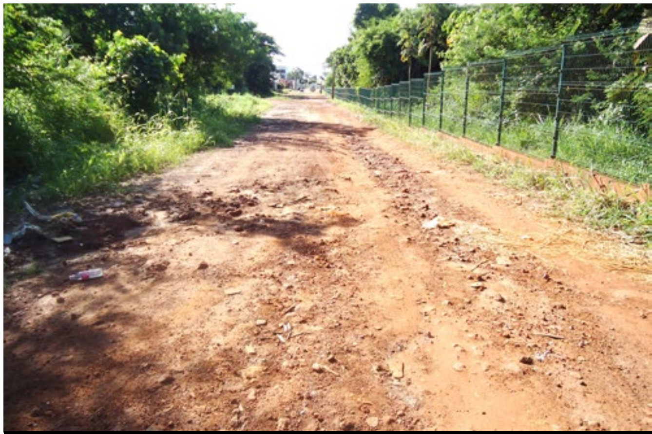
Obra de drenagem e pavimentação deverá custar mais de R$ 700 mil
