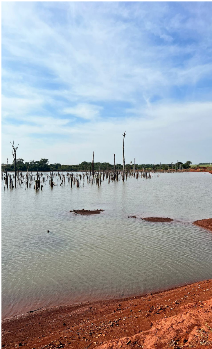
Redução considerável do nível de água na ETA Queima Pé
