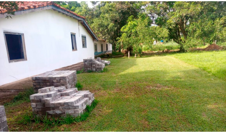
Trabalho realizado na Casa de Rondon
