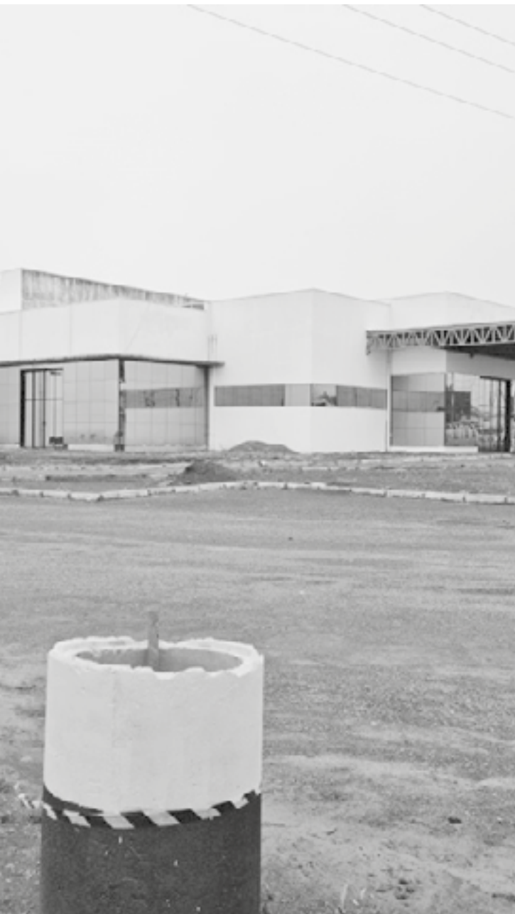
Obras serão efetivamente retomadas no dia 1º de março
