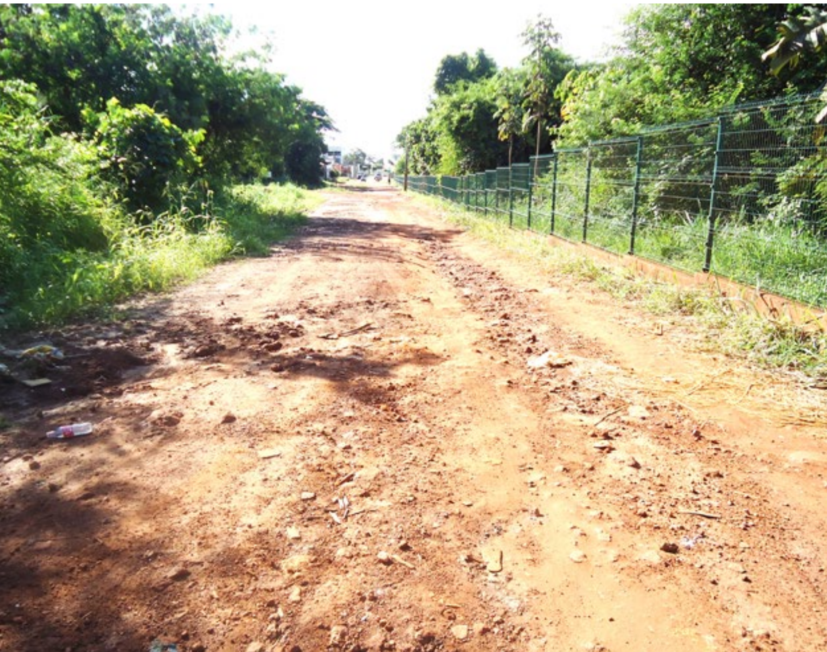
Obra de drenagem e pavimentação deverá custar mais de R$ 700 mil
