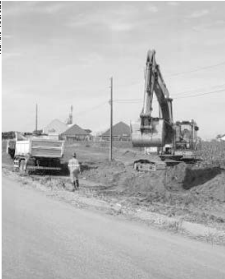
Trabalhos de terraplanagem e da rede de drenagem
