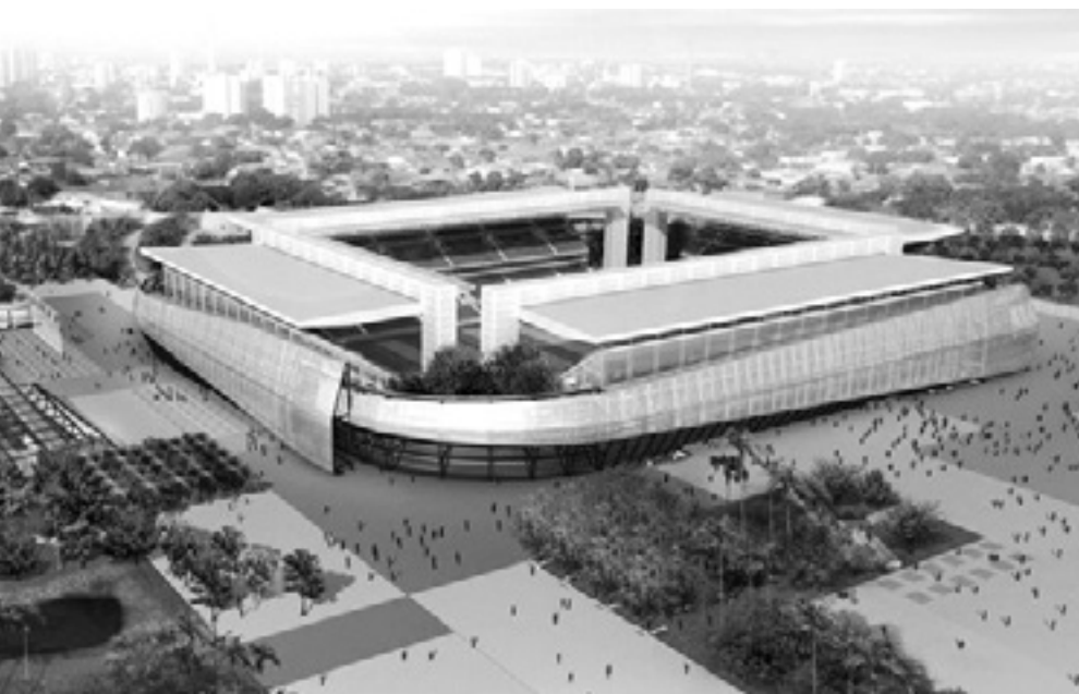
Obras estão 97% concluídas
