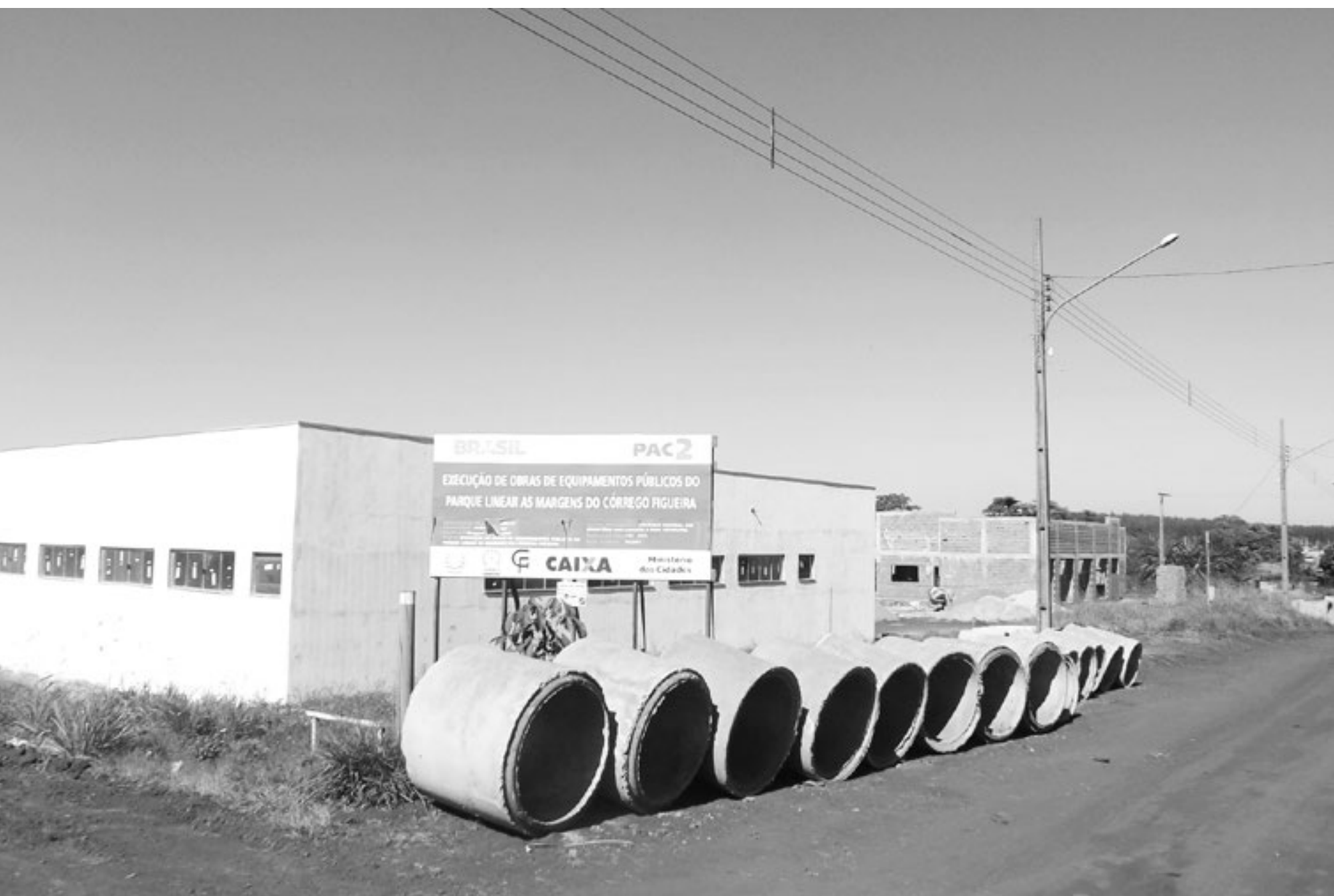
Mais de R$ 2 milhões dos valores atrasados são referentes aos trabalhos já realizados no Parque Figueira
