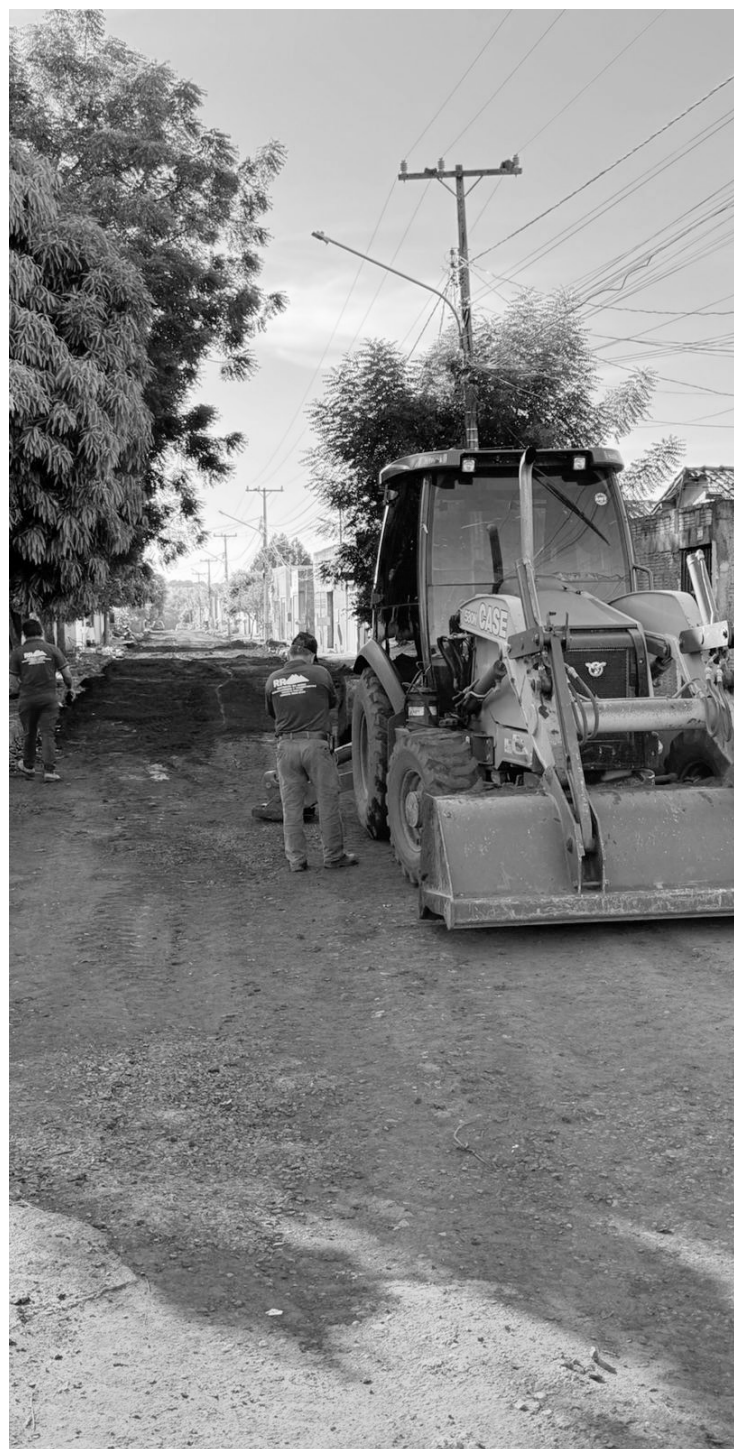
Obras seguem avançando no bairro
